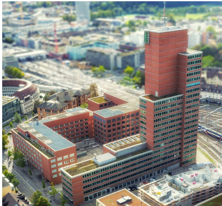
Gebäude SF, SI, SM, ST
