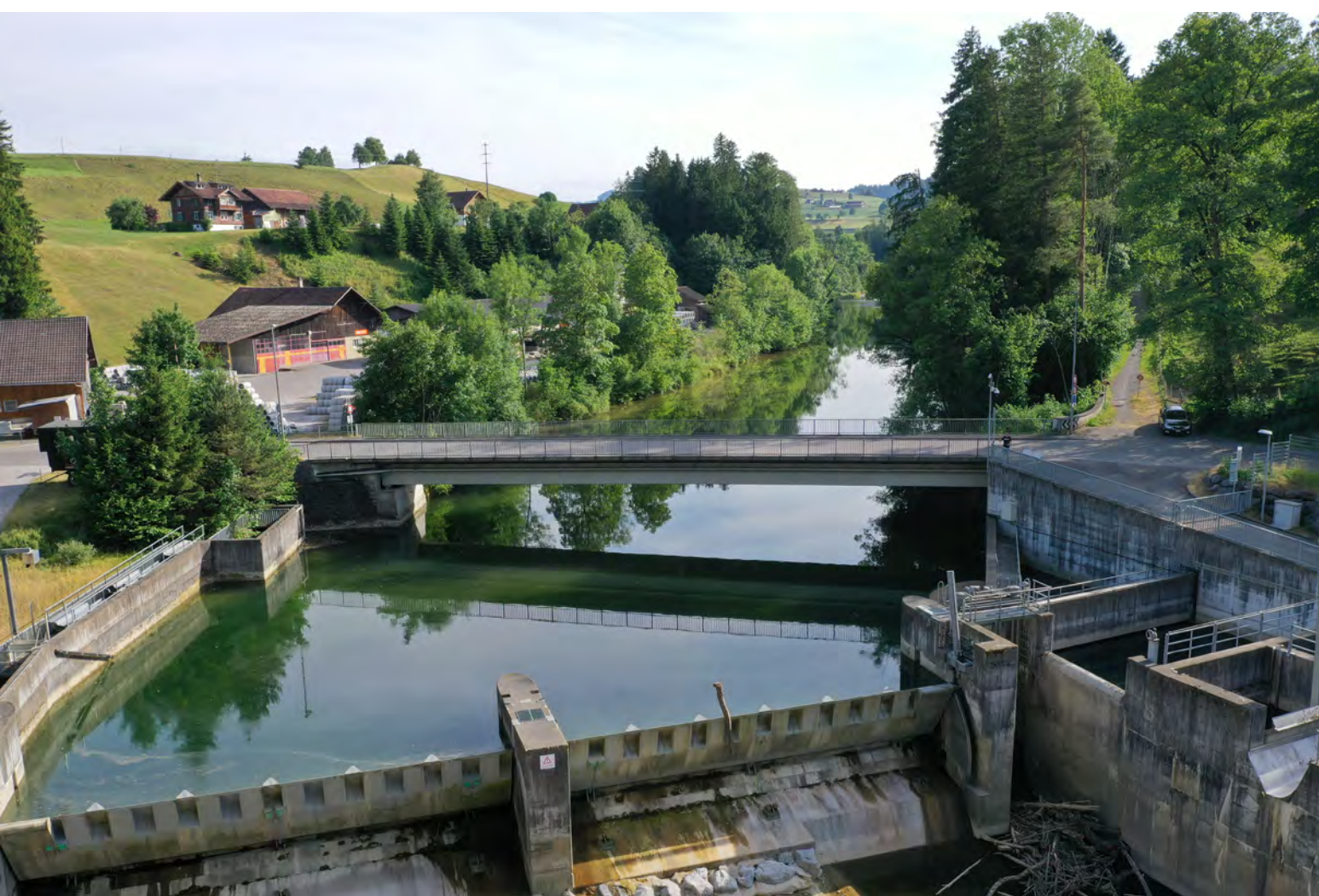
Abbildung 1: Bestehende Brücke Mühlau (Blickrichtung flussaufwärts)
