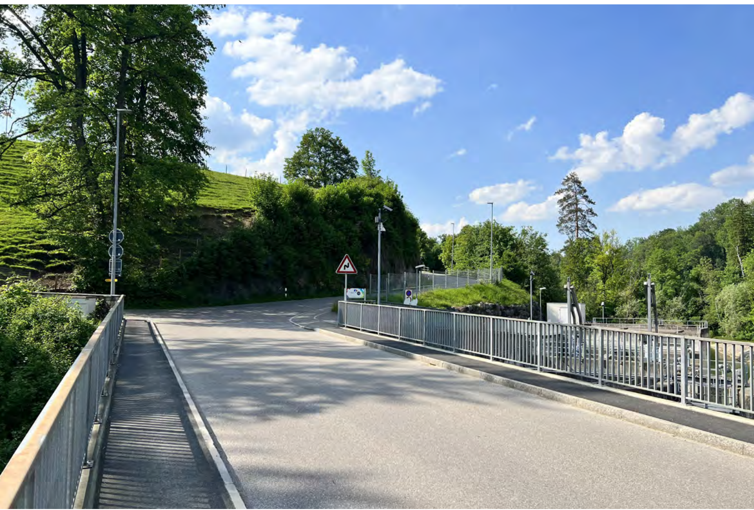
Abbildung 2: Bestehende Brücke Mühlau (Blickrichtung West)
