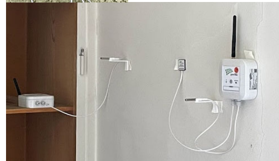
Abb. 2: An der Innenseite der Wand werden in der beheizten Zone des Gebäudes ebenfalls Wand-Oberflächen-temperatur und Lufttemperatur gemessen. Zusätzlich werden noch der Wärmefluss und die Luftfeuchtigkeit erfasst. Die Daten werden kabellos via Basisstation an einen Server übermittelt.
