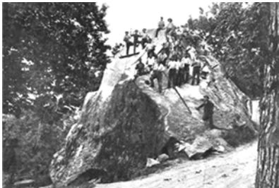
Findling als Steinbruch: eine der historischen Gefährdungsursachen
