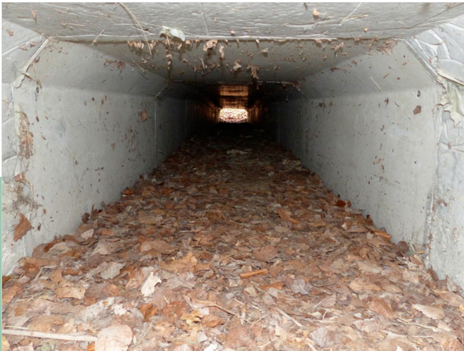
Fig. 1: passage pour amphibiens à Dätttau, près de Winterthur (photo: S. Brenneisen).
