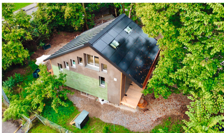
Blick auf das KREIS-Haus mit den zwei verschiedenen Solaranlagen und der Naturputz-Fassade
