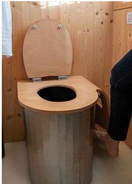
Die Trocken- trenntoilette verarbeitet den Inhalt in Dünger und Kompost für das Gemüse im Dach- garten.
