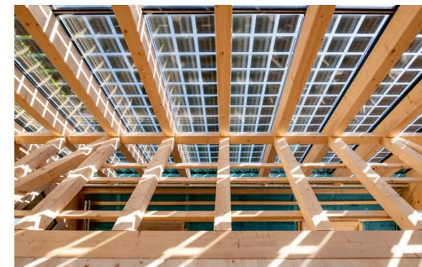
Durch die Solarmodule dringt Licht ins Dachgeschoss.
