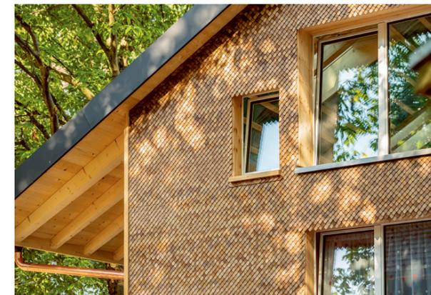
Für den Bau des Testhauses dienten Lehm, Holz und rezyklierte Elemente.
