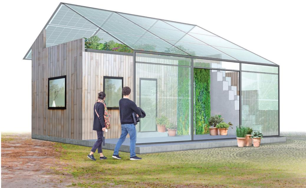
Konzipiert wurde das kleine Haus mit einer Gesamtfläche von 40 m<sup>2</sup> als modulares System, das transportierbar ist und ohne Produktion von Abfällen auf- und wieder abgebaut werden kann.
