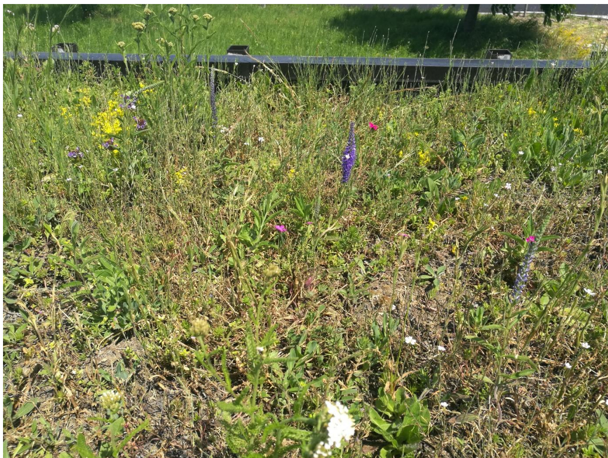
Abbildung 12: Detailansicht der Dachbegrünung
