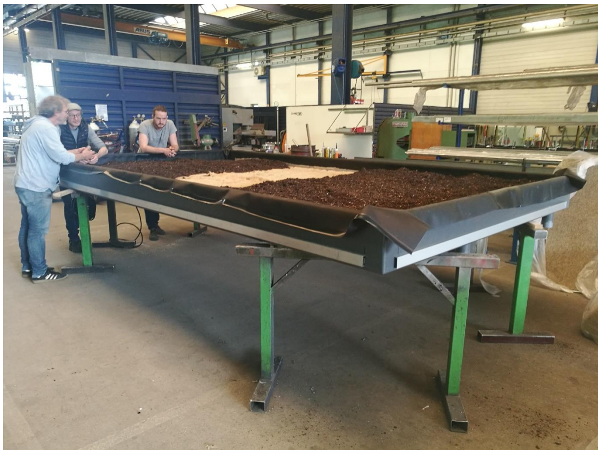
Abbildung 8: Vorbereitung Dach mit Hanffasermatten und Substrat
