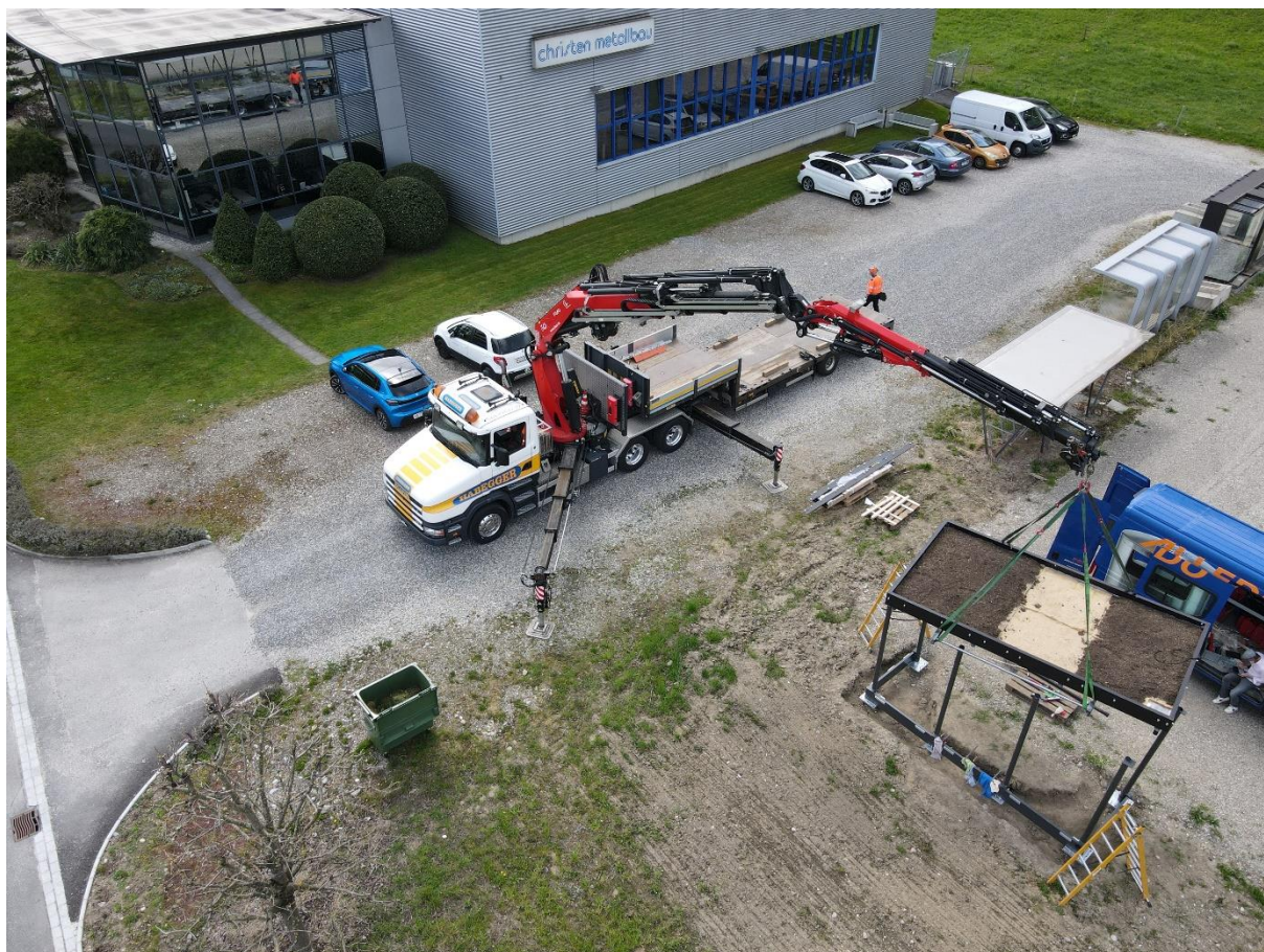
Abbildung 9: Montage Dach auf Konstruktion mittels Kran
