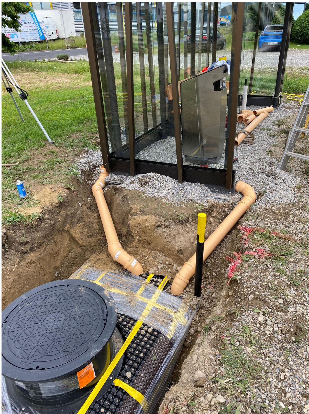
Abbildung 10: Regenwassertank verrohrt und in Boden eingelassen
