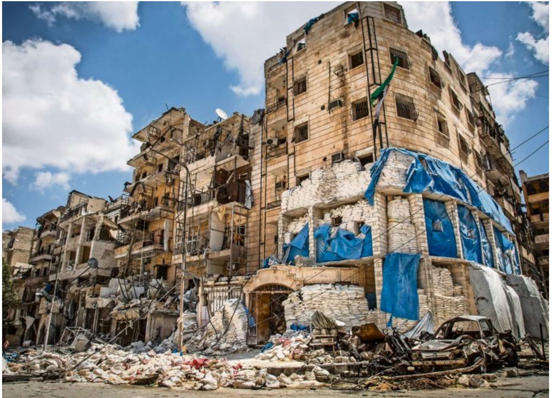
Dieses Spital im Osten Aleppos wurde nach Luftangriffen behelfsmässig repariert – im Innern arbeiten die Ärzte weiter.
