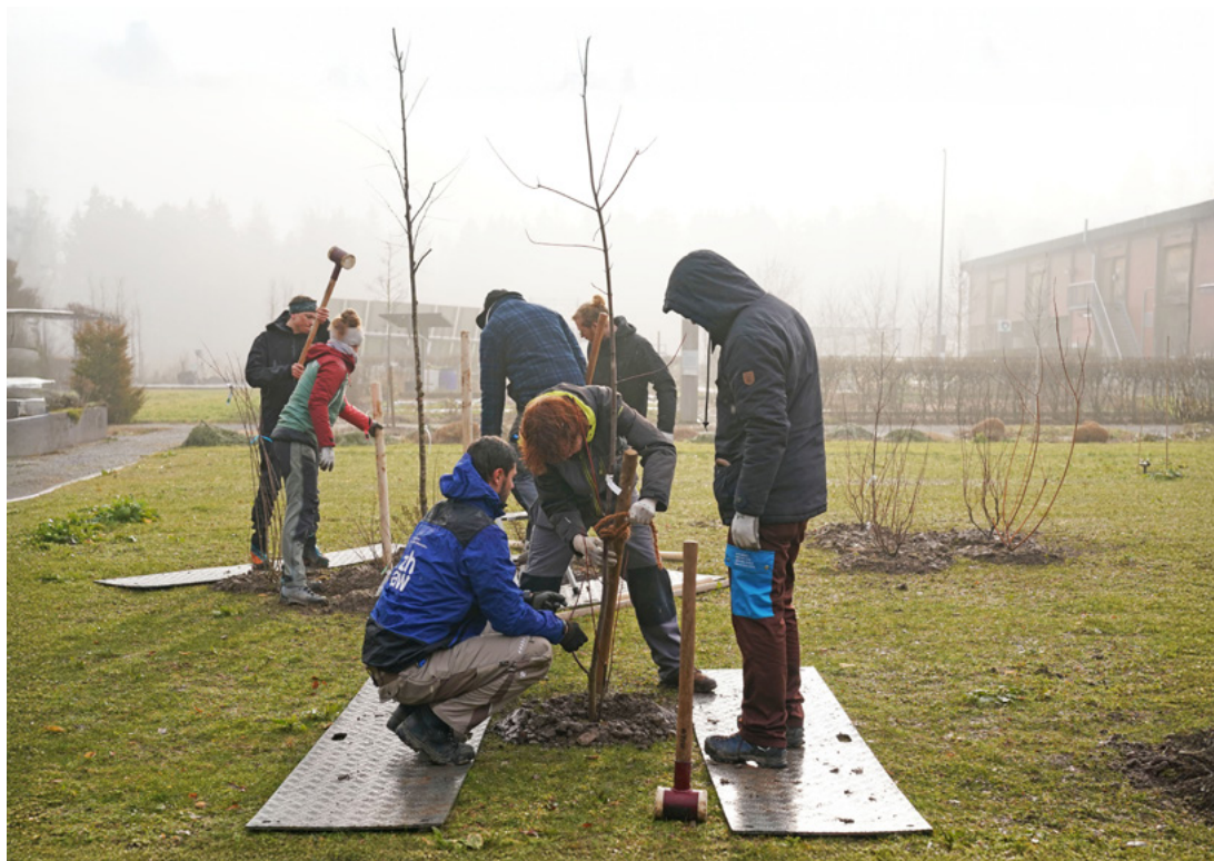
Erstellen der Baumbefestigungen unter Berücksichtigung des Bodenschutzes
