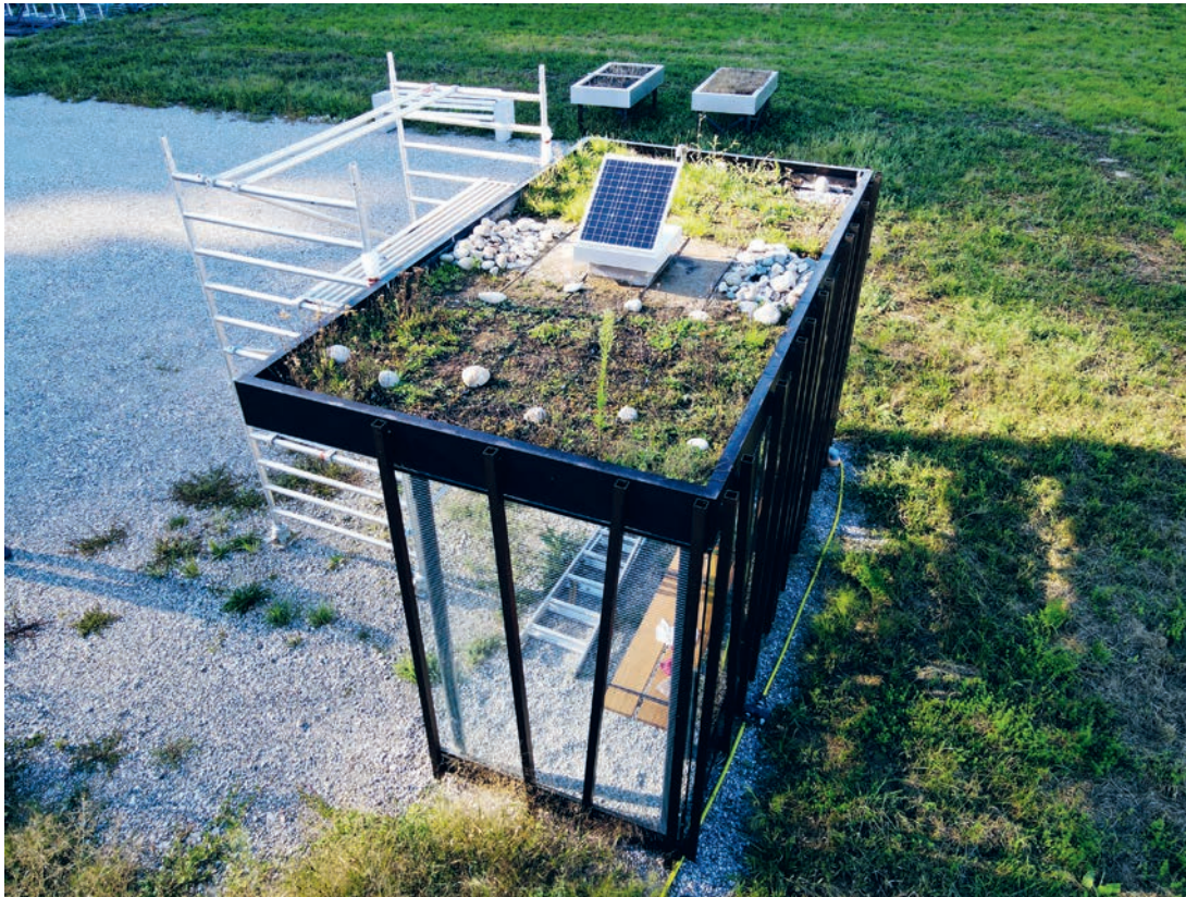
Buswartehäuschen mit PV, Wildbienensand, Steingärten und Totholzelementen sowie Dachbegrünung aus einheimischen Blumen und Kräutern.
