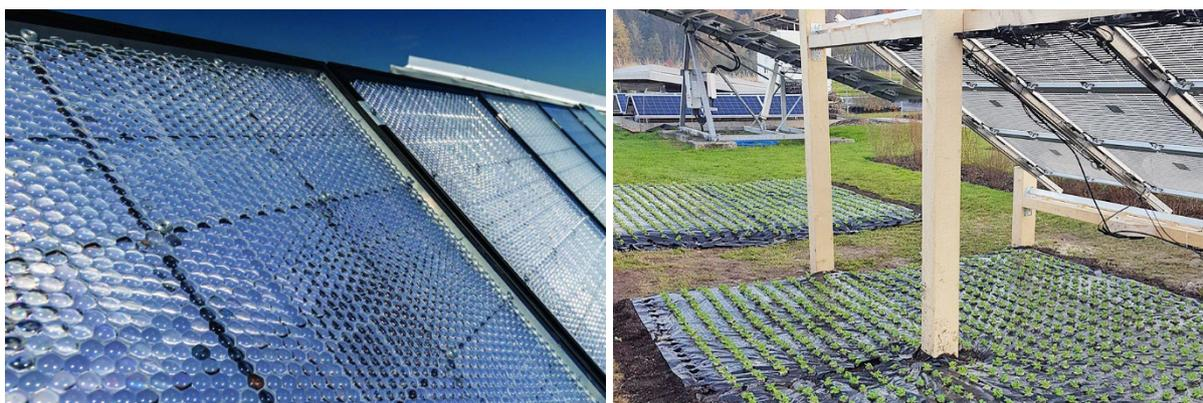
Die Solarmodule von Insolight (Abbildung links) sind transparent und besitzen eine Mikro-Tracking-Technologie, mit der die Lichtdurchlässigkeit angepasst werden kann. Am Campus Grüental in Wädenswil wird Nüsslisalat unter den Modulen angebaut (Abbildung rechts).
