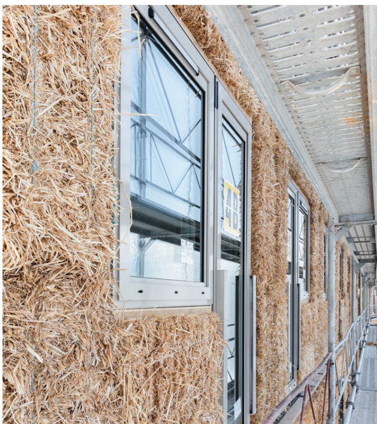
Figure 31 : La durabilité est également au premier plan pour le bâtiment lui-même : l'isolation de la façade est composée de bottes de paille et d'argile © Julien Gremaud
