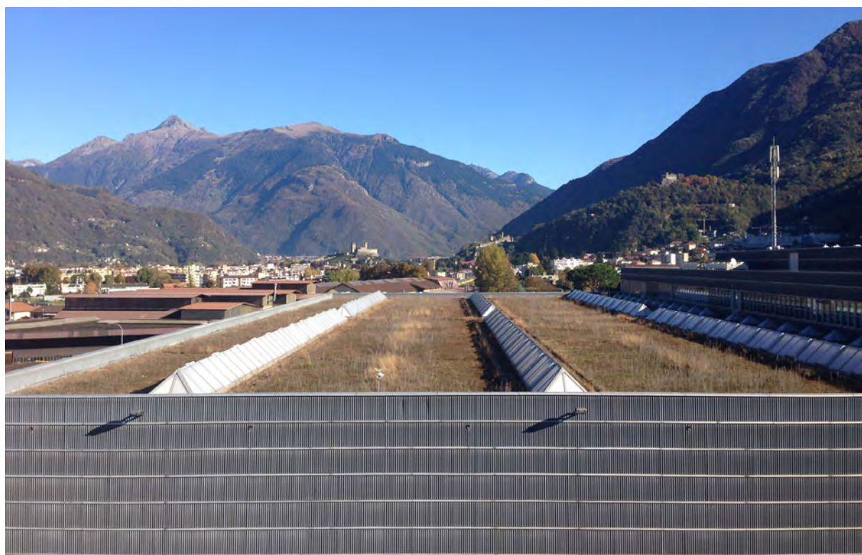
Figure 48 : Des espèces rares de prairies sèches ont été établies sur la surface du toit de l'ancien Swisscom Service Center © Chiara Catalano
