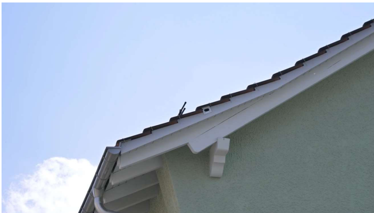
Figure 39 : Aide à la nidification pour martinets noirs intégrée dans le chéneau © Commune de Cham
