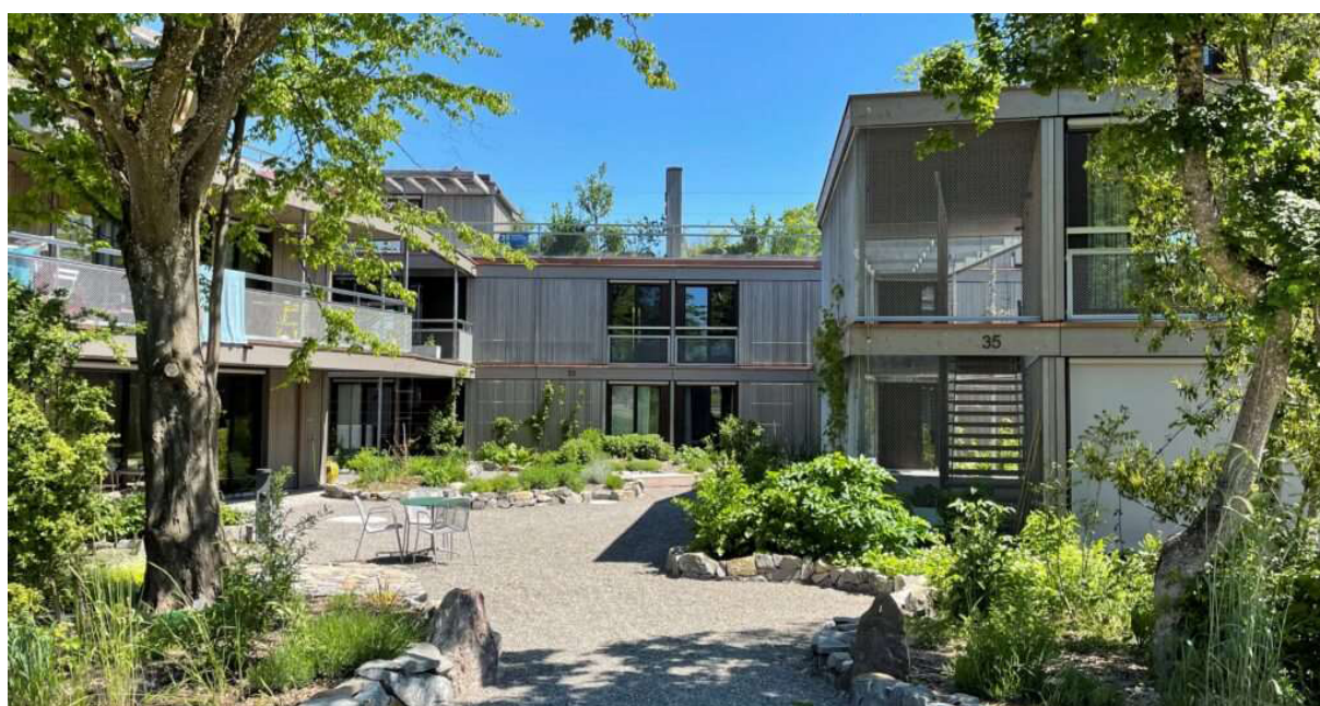
Figure 42 : Le bâtiment a été planifié et conçu en même temps que les espaces extérieurs © Ramon Grendene
