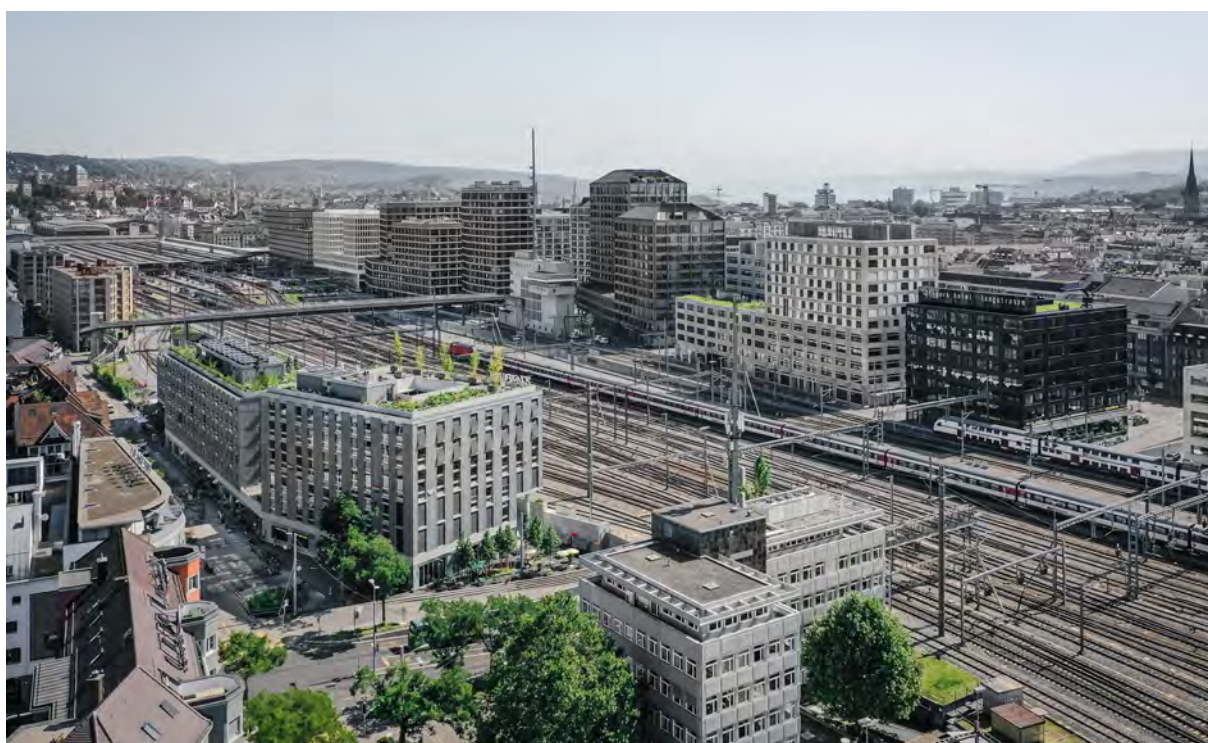
Figure 44 : Le Zollhaus se trouve sur une étroite bande de terrain le long des voies ferrées, au milieu du quartier de la Langstrasse © Annett Landsmann
