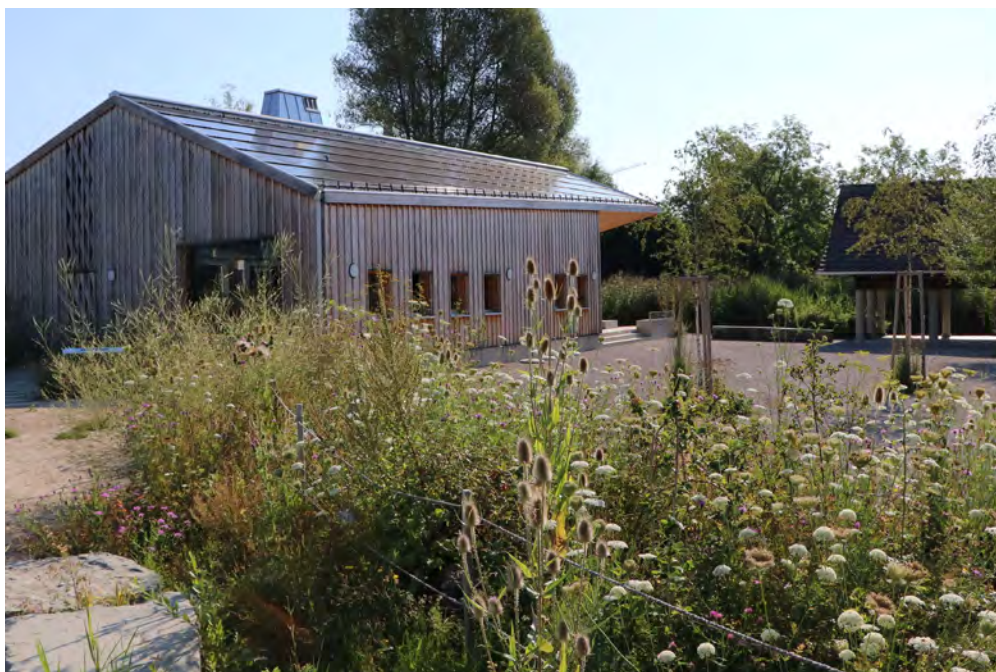
Figure 7 : Le bâtiment en bois durable du Centre Nature du Pfäffikersee, intégré dans un environnement propice à la biodiversité © Centre Nature du Pfäffikersee
