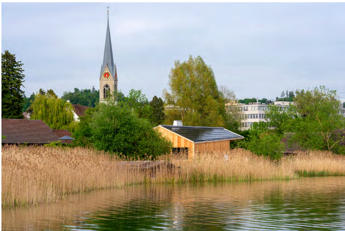
Figure 13 : Le centre nature du Pfäffikersee est situé de manière idyllique sur la rive du lac et jouxte directement la zone de protection de la nature et du paysage © Marco Blessano
