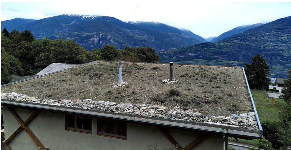
Figure 34 : Toitures végétalisées dans des conditions climatiques très sèches © Nathalie Baumann
