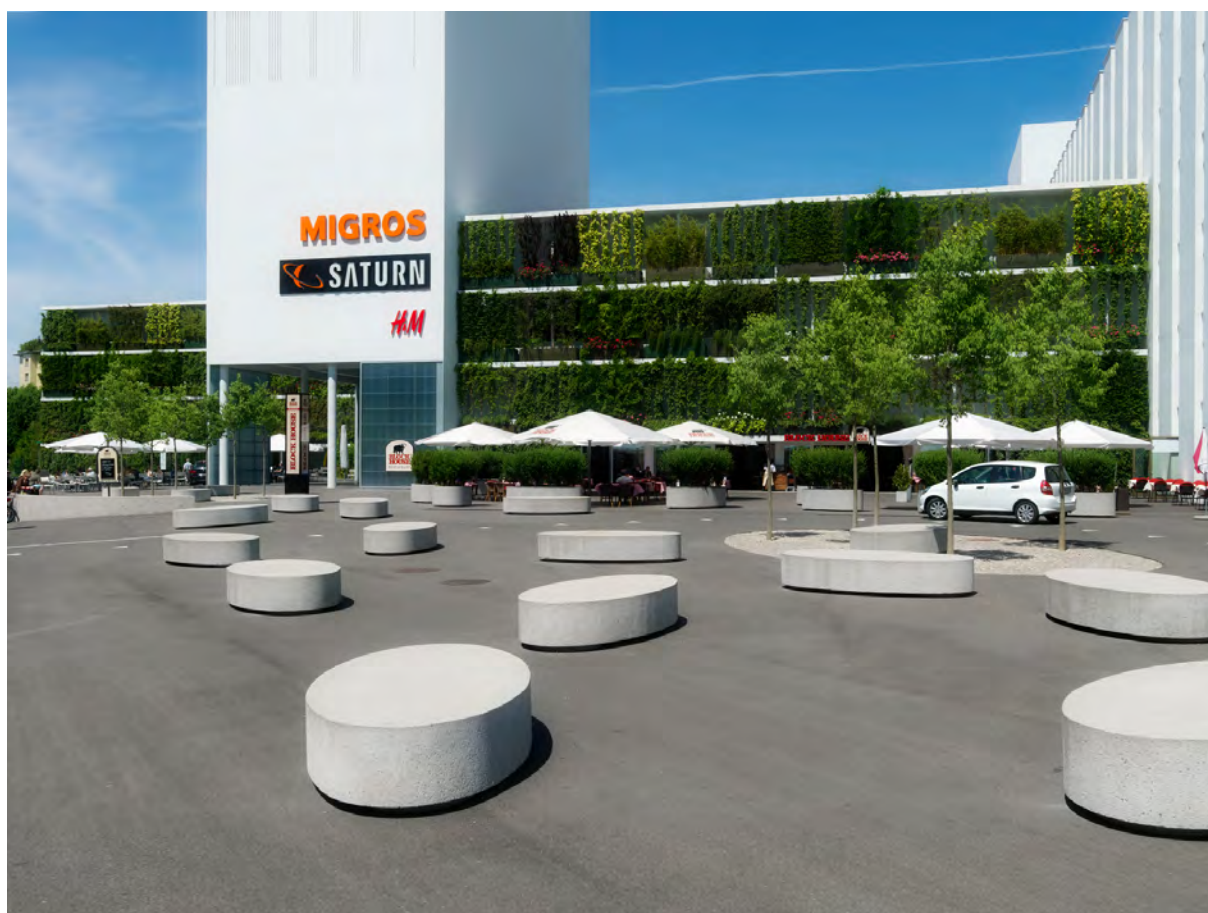
Figure 24 : Le centre commercial Stücki à Bâle avec sa végétation verticale orientée vers le sud. La façade ouest végétalisée, non visible ici, a pu être réalisée avec des plantes grimpantes (racines dans le sol). © Fahrni und Breitenfeld GmbH
