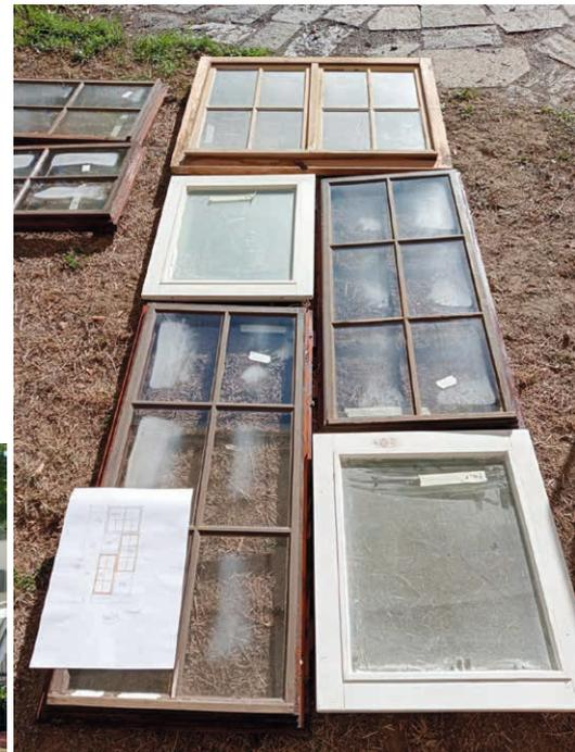
Auslegeordnung für die neue Fassade mit Detailzeichnungen der Architektin für das Zusammensetzen
