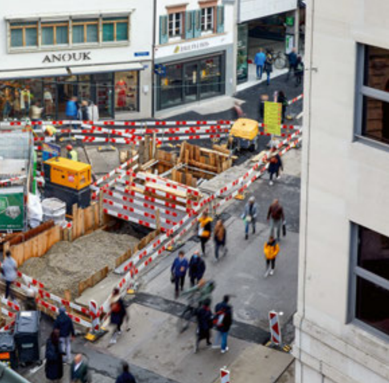
In dicht bebauten Gebieten ist Fernwärme ein bevorzugtes Heizsystem: Baustelle der Energieversorgerin IWB in der Freien Strasse in der Basler Altstadt. Foto: IWB/Timo Orubolo
