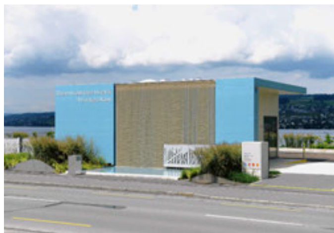
Die Überbauung Horgen-Promenade kommt bei der Versorgung mit Heizwärme, Warmwasser und Kälte (Raumklimatisierung) seit Ende 2012 ohne fossile Energien aus. Als Wärme- und Kältequelle dient der Zürichsee. Wärmepumpen stellen das gewünschte Temperaturniveau sicher. Im Bild: das Seewasserwerk, bei dem Wasser aus dem Zürichsee entnommen wird, um es für den Wärmeverbund Horgen-Promenade und parallel auch für die Bereitstellung von Trinkwasser zu nutzen. Foto: AEW Energie AG
