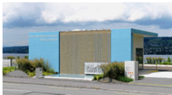
Depuis fin 2012, le complexe immobilier Horgen-Promenade fonctionne sans énergies fossiles pour son approvisionnement en chauffage, en eau chaude et en climatisation. Le lac de Zurich fait office de source de chaleur et de froid. Les pompes à chaleur garantissent le niveau de température souhaité. Sur l'image : la centrale hydraulique lacustre qui prélève l'eau du lac de Zurich pour l'utiliser pour le réseau de chauffage Horgen-Promenade et, parallèlement, pour assurer l'approvisionnement en eau potable.
