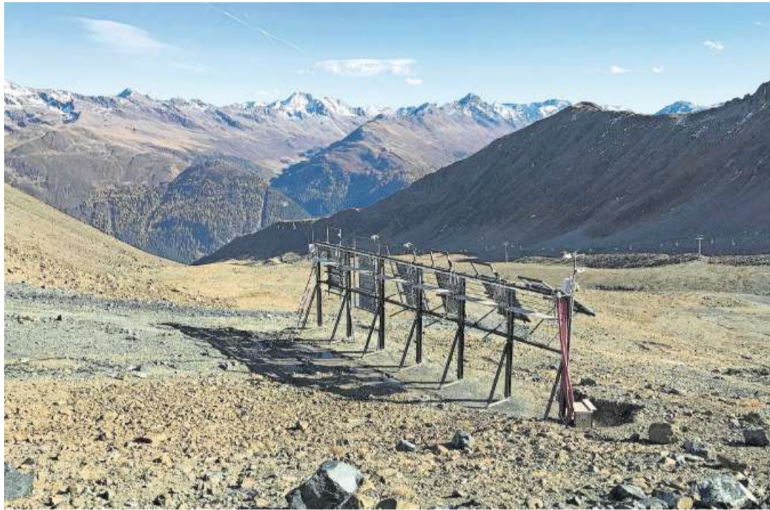
Solaranlagen in den Bergen liefern eineinhalb Mal mehr Strom als solche im Mittelland: die Testanlage auf der Totalp mit Blick auf die Alpen im Südosten.
