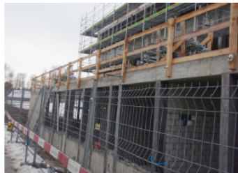
1 Korrekter dreiteiliger Seitenschutz gemäss SN EN 13374
