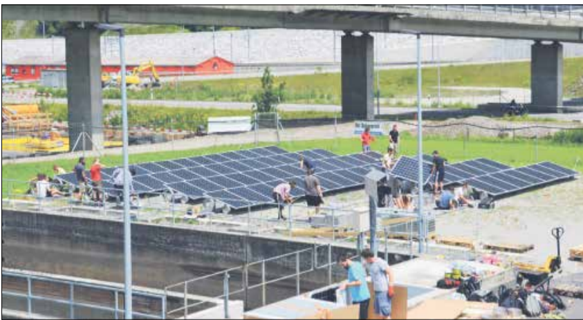
Die 180 Quadratmeter grosse Fotovoltaikanlage auf dem ehemaligen ARA-Erstfeld-Gebiet für den Betrieb der Laboranlage der «Basis57». FOTO: ZVG
