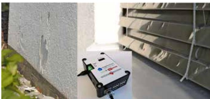
Abb. 2: Hagelschäden an der Gebäudehülle (links: aufgeschlagener Putz an WDVS, rechts: zerbeulte Lamellenstore) lassen sich einfach verhindern, mit der Verwendung hagelsicherer Bauteile (hagelregister.ch) und einer automatischen Hagelwarnung für Lamellenstoren (Mitte: Signalbox zur Nachrüstung von «Hagelschutz – einfach automatisch» an bestehende Gebäude).
