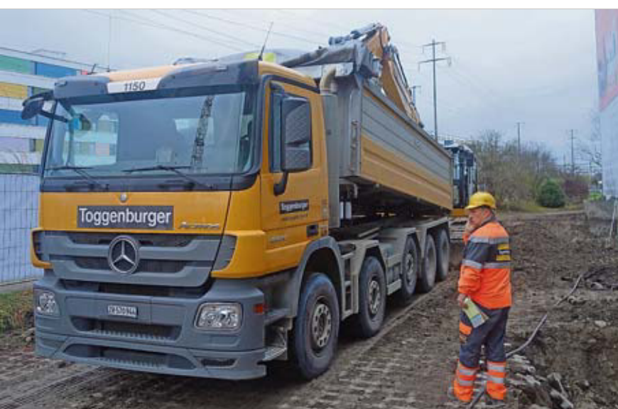
Auf der Rückfahrt nimmt Andreas Lenk Aushub mit.
