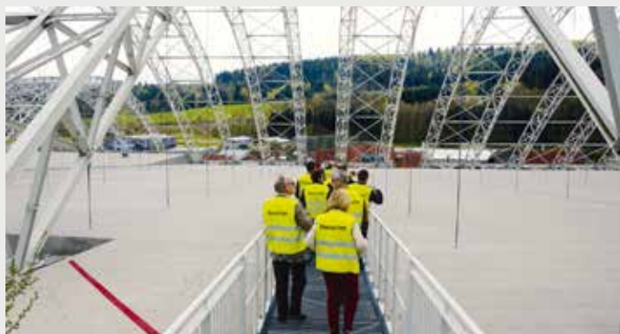
Die riesigen Stahlbögen stützen das Dach der 240 mal 170 Meter grossen Halle der Sondermülldeponie Kölliken (AG).
