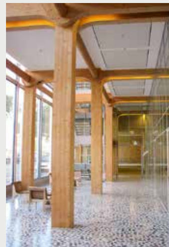
Die Holzbalken dienen sogar dem Brandschutz.
