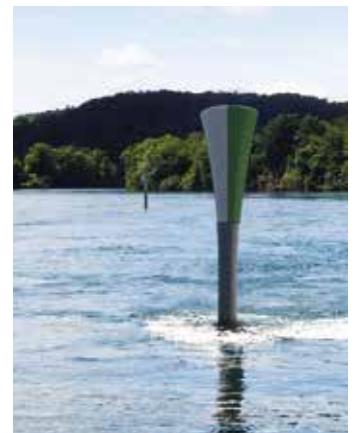
Die Kippstange neigt sich bei Kollision in Fließrichtung.
