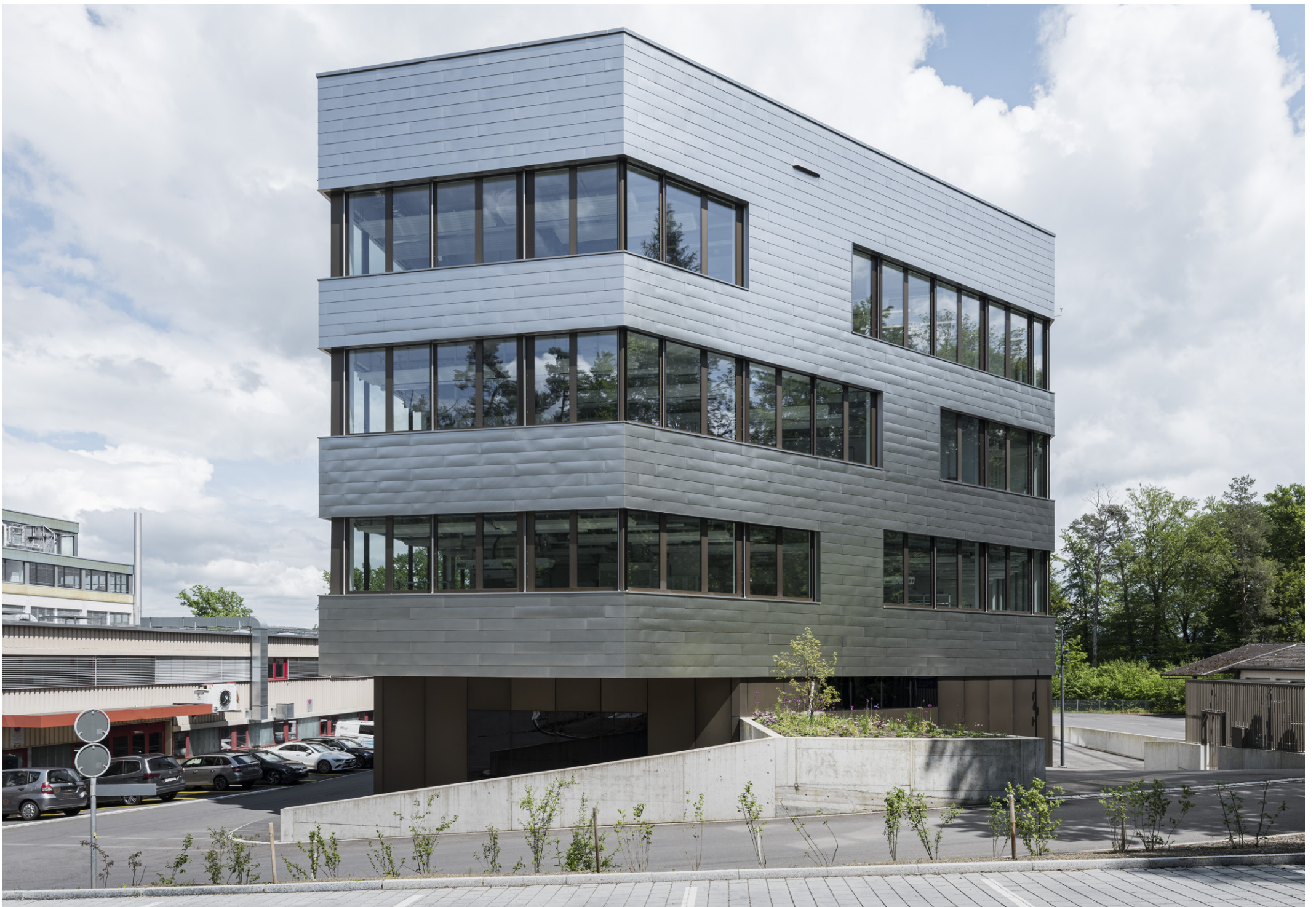
Im neuen Laborgebäude können Produkte umfassend vom Rohstoff über die Verarbeitung bis hin zum Lebensmittel- und Qualitätsmanagement sowie zum Marketing erforscht werden.
