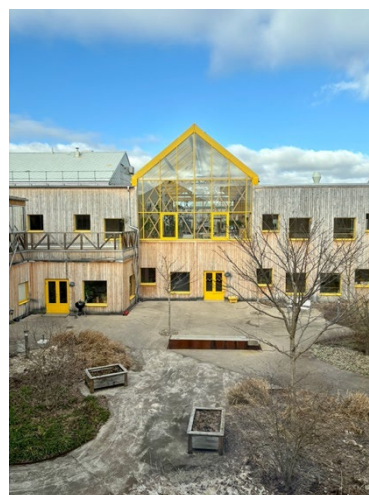
Bild 5: Sicht auf Innenhof vom Altersheim
