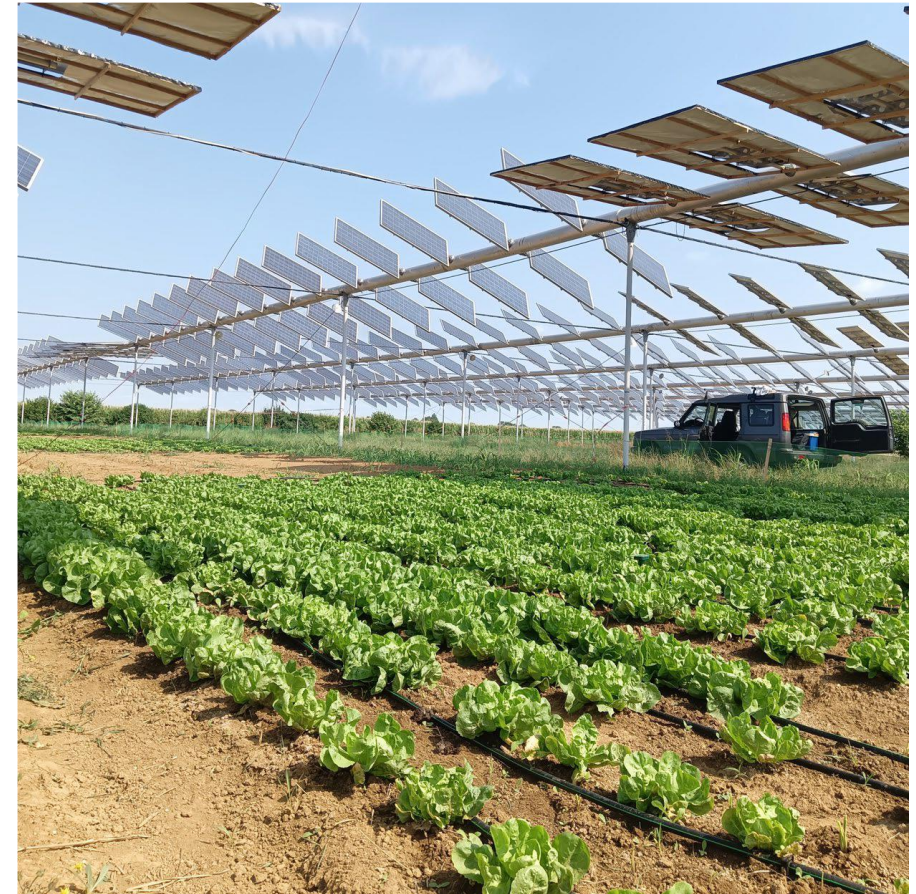
Foto: Agri-PV Anlage mit 3D-Achsen-Trackern in Italien, Quelle Remtec
