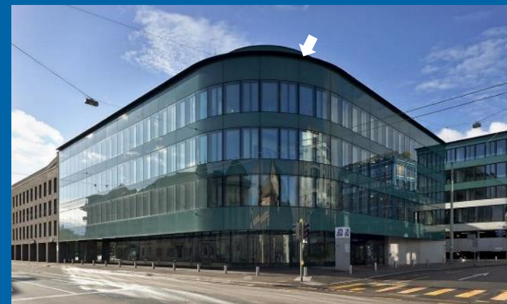
Gebäude TN, Technikumstrasse 71, Winterthur
