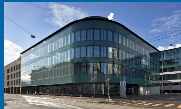
Gebäude TN, Technikumstrasse 71, Winterthur
