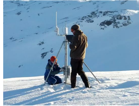
Redundantes Funksystem (Sub 1-GHz, Überwachung Naturgefahren)
