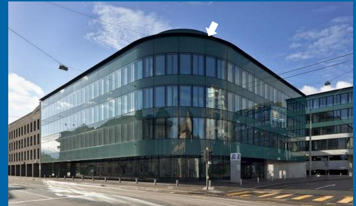
Gebäude TN, Technikumstrasse 71, Winterthur
