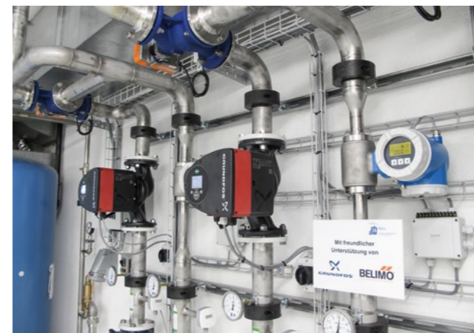
Der neue Hydraulikanschluss mit präzisen Messgeräten im Kälte Labor des IEFE ermöglicht Tests an temporär angeschlossenen Kältemaschinen und Wärmepumpen.
