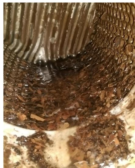
**Bild 4** Ablagerungen im Wärmeaustauscher.
