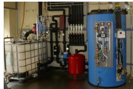
Der komplette Aufbau der Anlage sowie die messtechnische Ausstattung kann dem **R&I-Schema** entnommen werden. (Dieses beinhaltet ebenfalls den ORC-Anlagenteil, da beide den gleichen Kühlkreislauf nutzen.) Die Erfassung, Aufzeichnung und Visualisierung der Messdaten erfolgt durch ein NI-Messdatenerfassungssystem mit LabView-Visualisierung.
