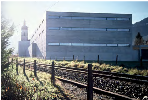
Fassade zeichnet den inneren statischen Aufbau – Gebäude bezieht sich auf die Geometrie des Bestandes und nicht auf die Bahnlinie
