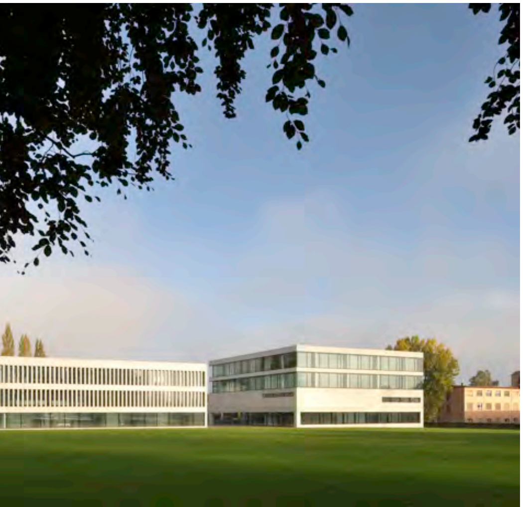
Neubauten Pädagogische Hochschule Thurgau in Kreuzlingen mit anschliessendem Sportplatz
