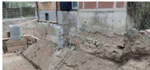
Bodenplatte des Anbaus Floor slab of the extension
