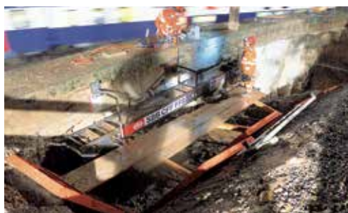
Durchführung der Querkraftversuche während einer Nachtschicht Shear force experiment during a night shift
