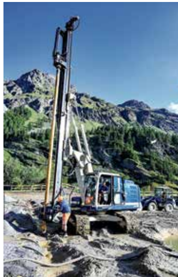
Einspülen von Wellpointfiltern in Silos, Graubünden Jetting of wellpoint filters in Silos, Graubünden
