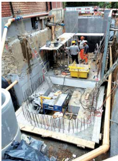
Aushub des Anbaus Excavation for the extension
