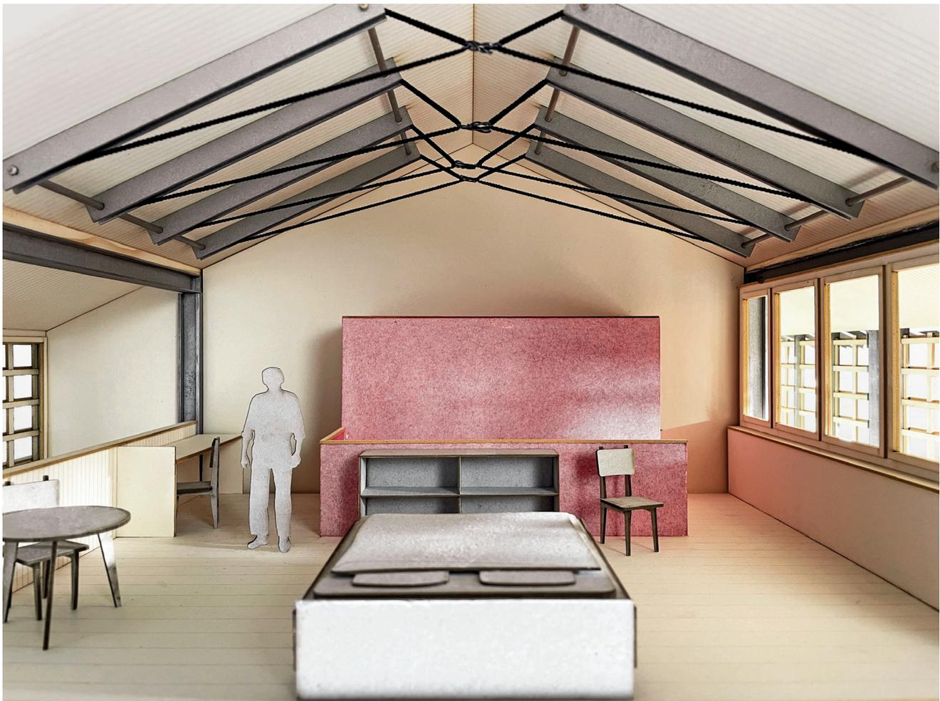
Abb. 2: Zwei Dachhälften, dünne Stahlplatten und filigrane Zugstäbe überspannen das obere Zimmergeschoss des Neubaus.
