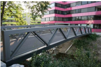
Brücke in Verbundbauweise Stahl/FVK
