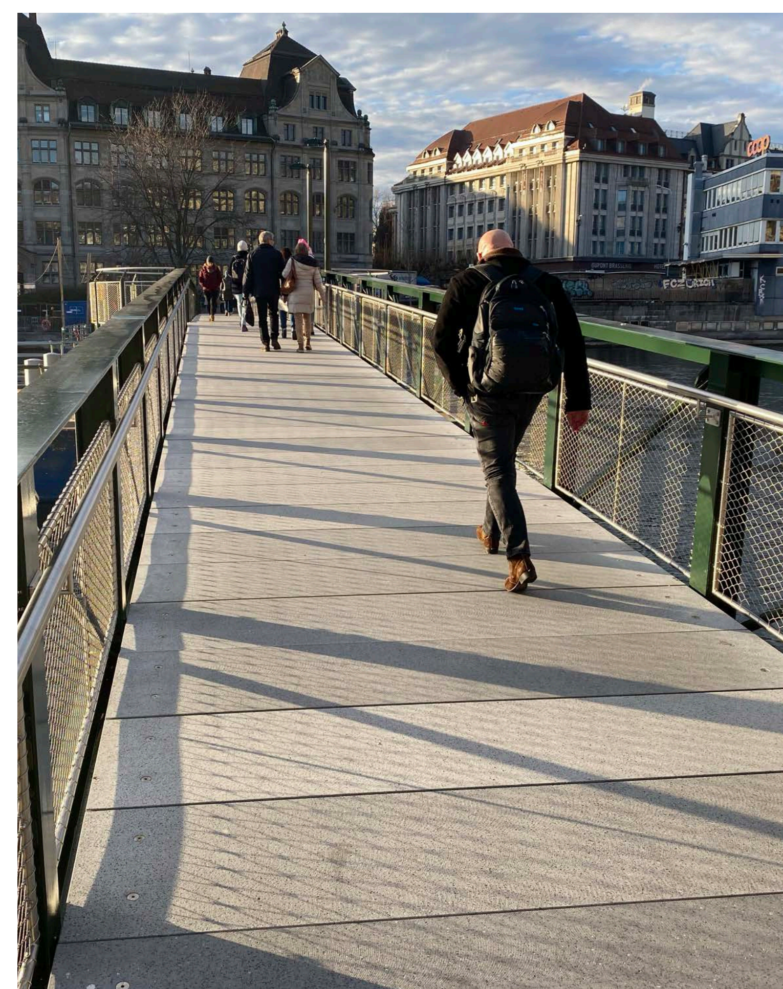
Bohlenbelag Mühlesteig, Zürich
