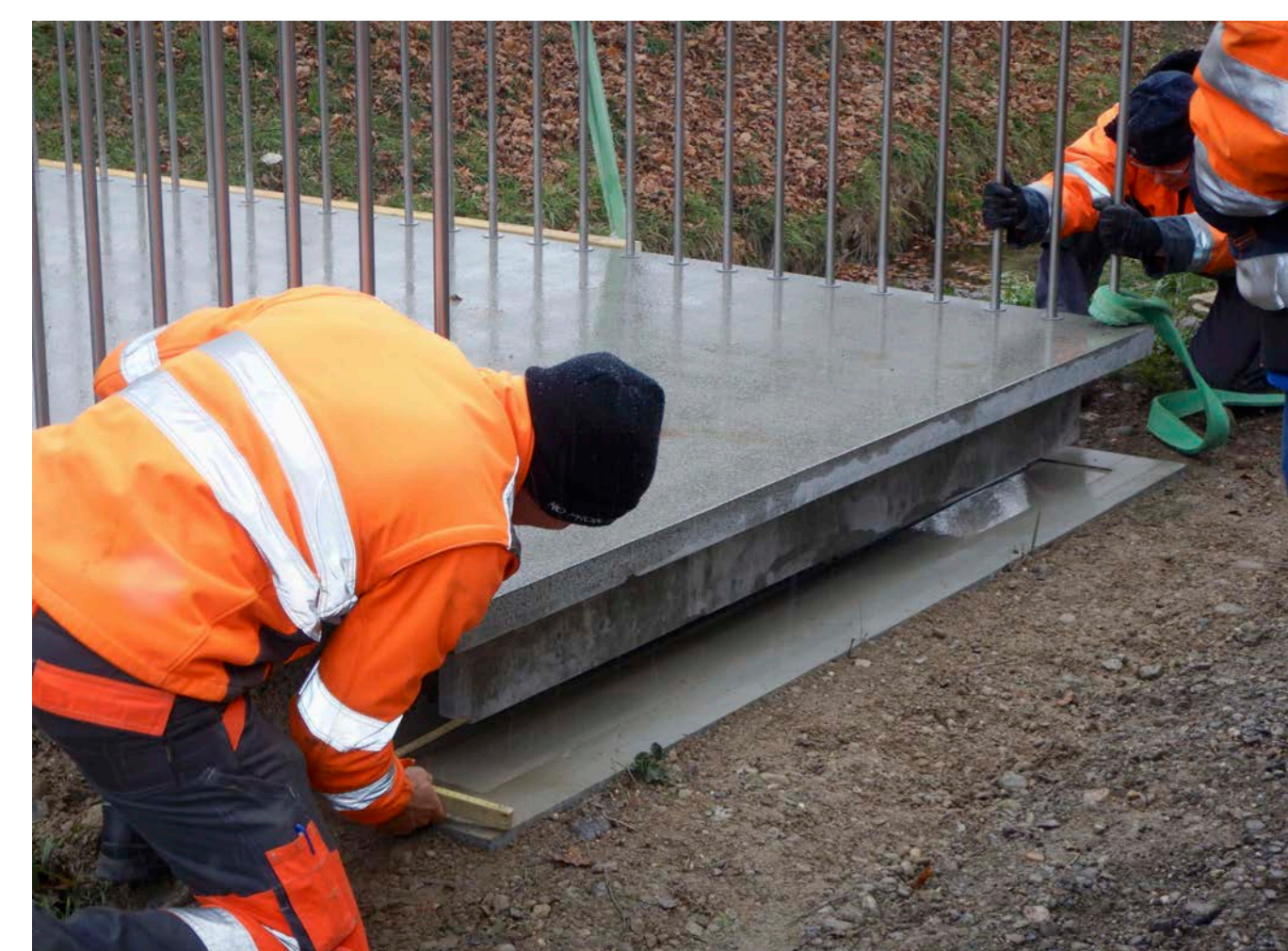
4. Verbindung Brücke mit Auflager
