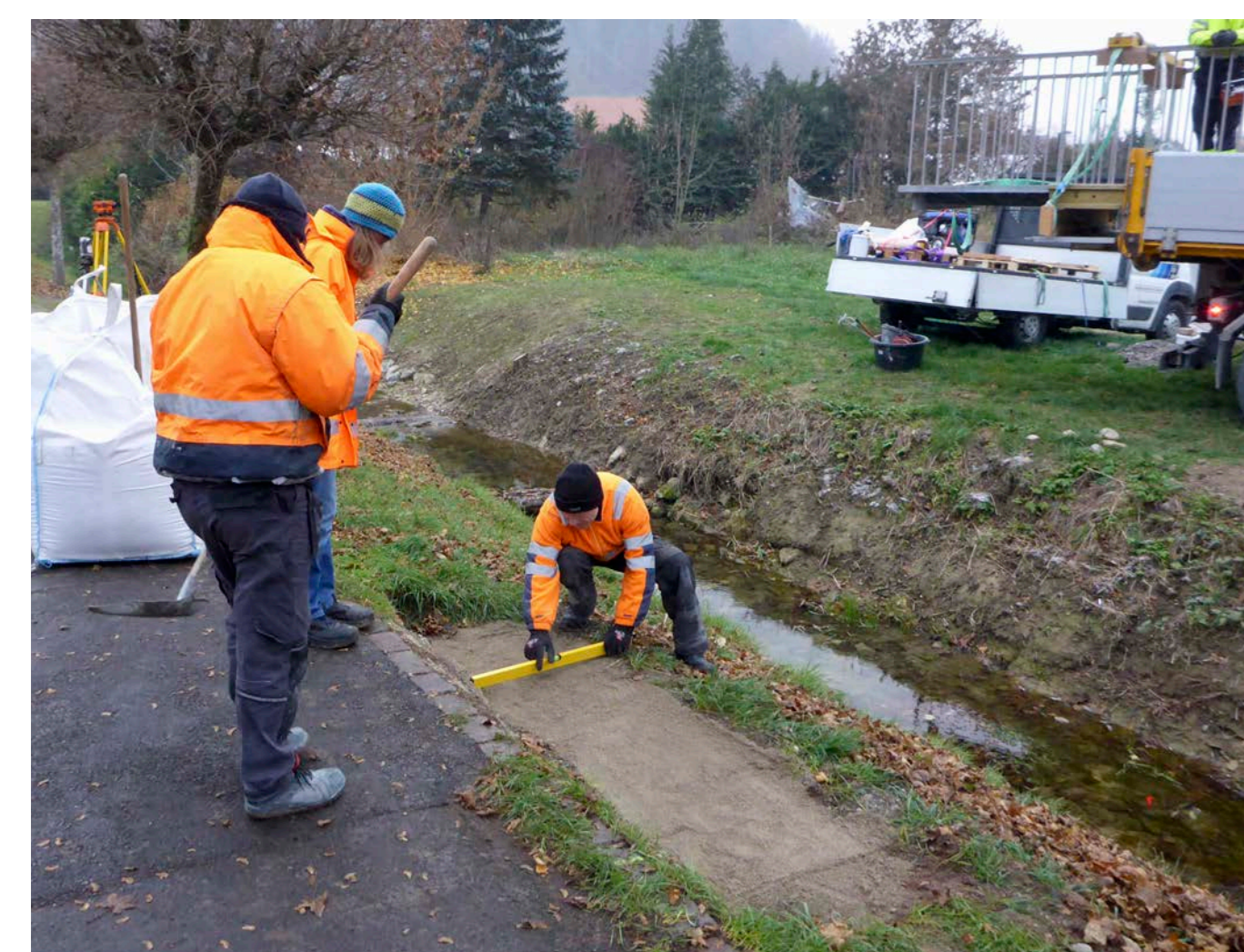
1. Aushub und Kieskoffer (kein Beton notwendig)
