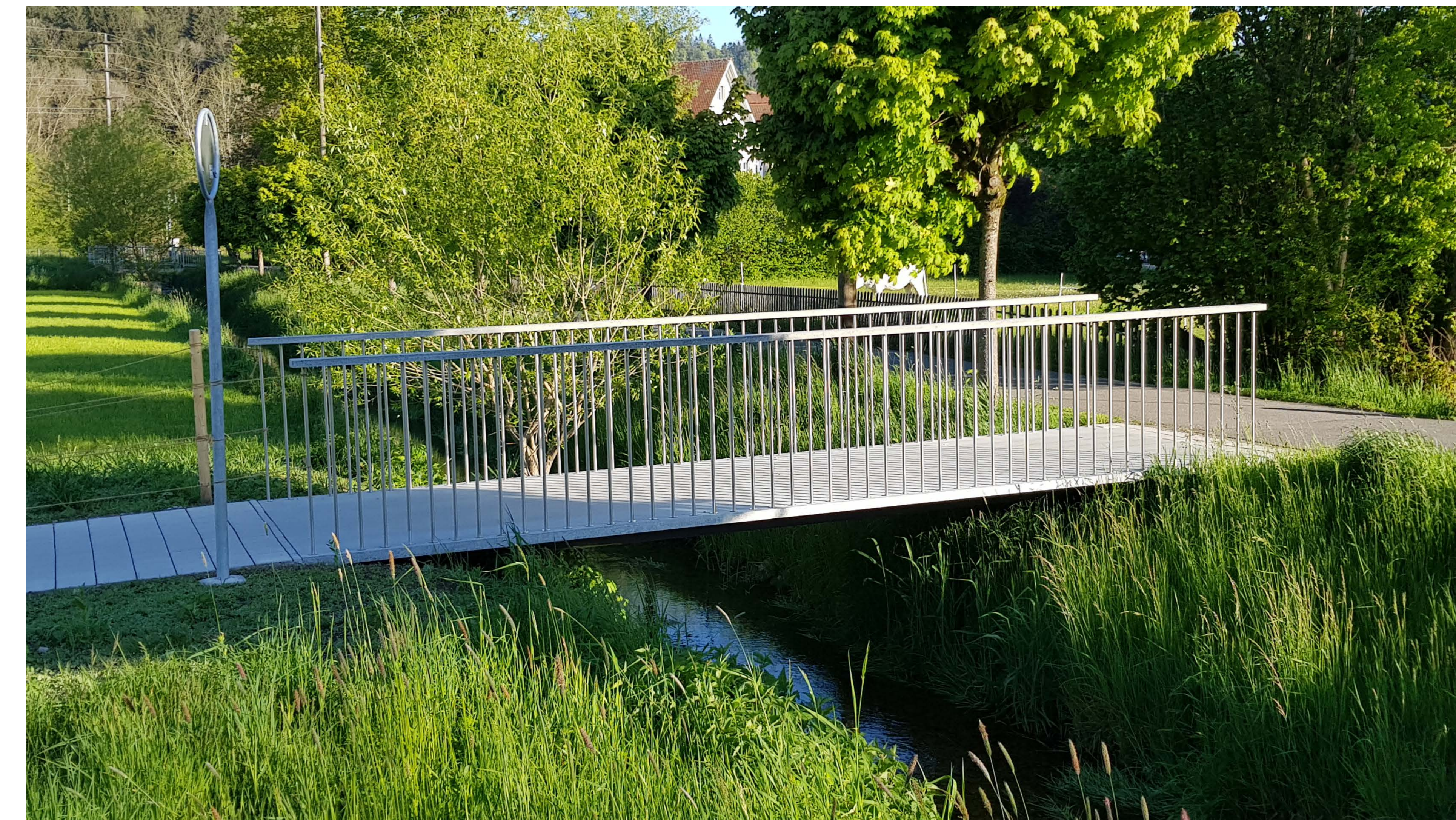
6. Brücke im fertigen Zustand
