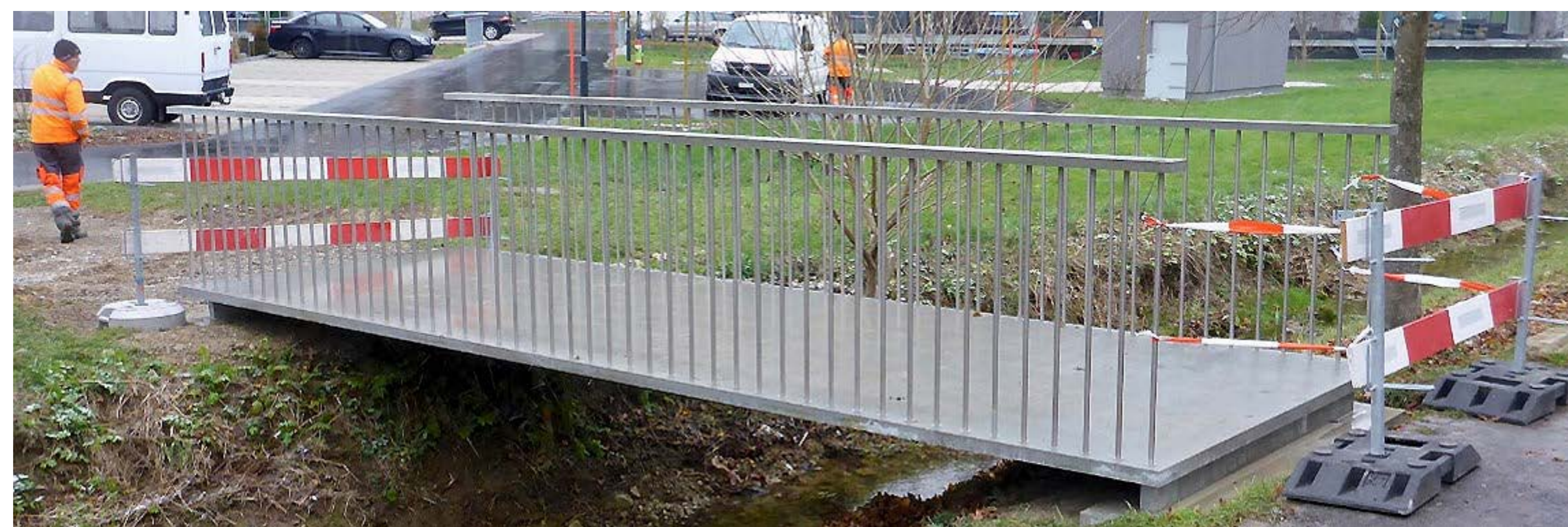
5. Sicherung der fertigen Brücke nach einen Arbeitstag auf der Baustelle
