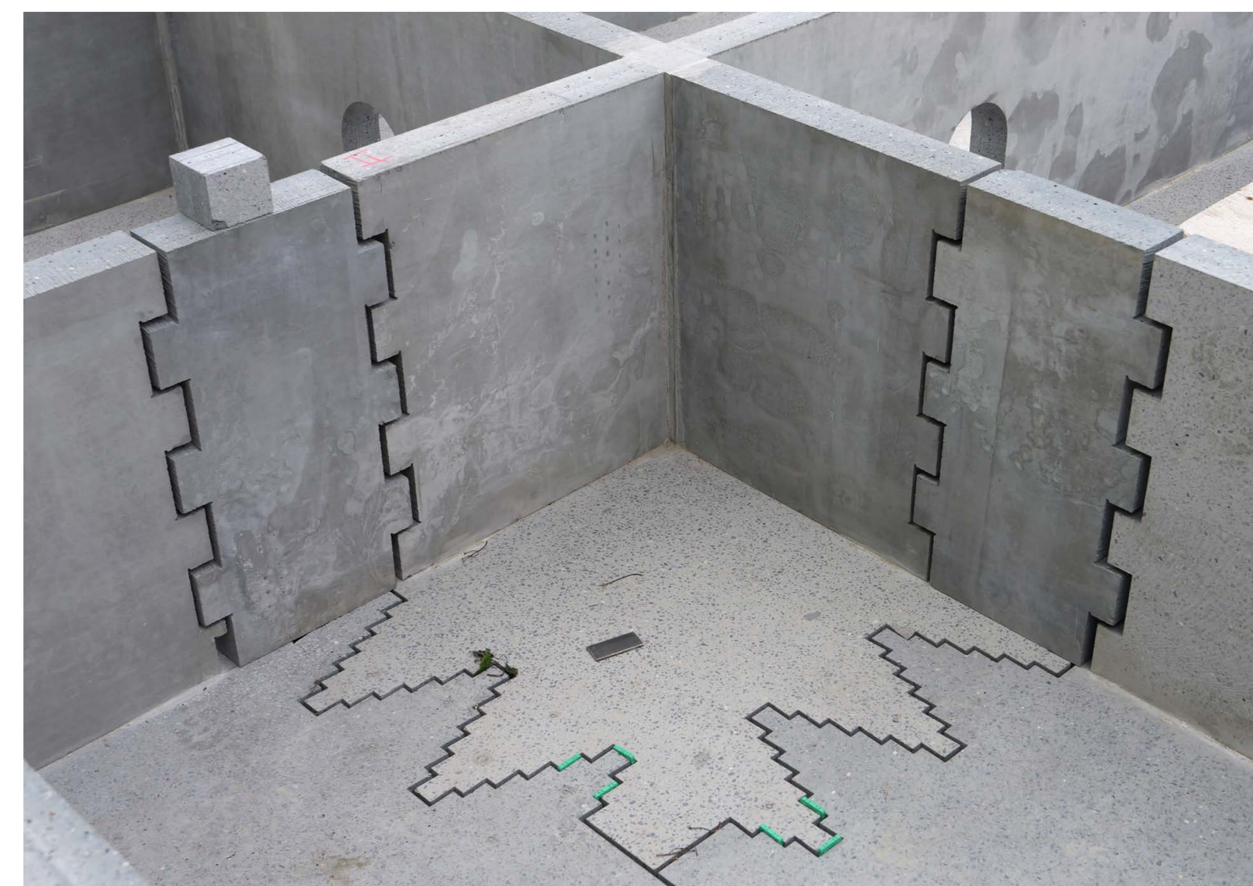
Verbindungsdetail von drei Grossbauteilen vor dem Vermörteln der Fugen.
