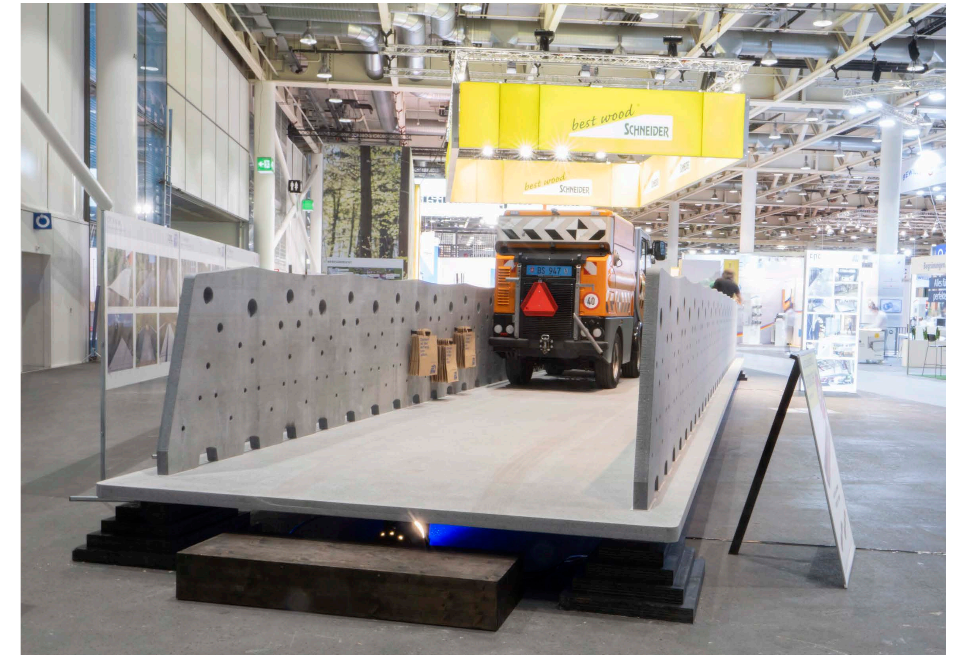
Optima-Brücke an der Swissbau - 17 m Spannweite
