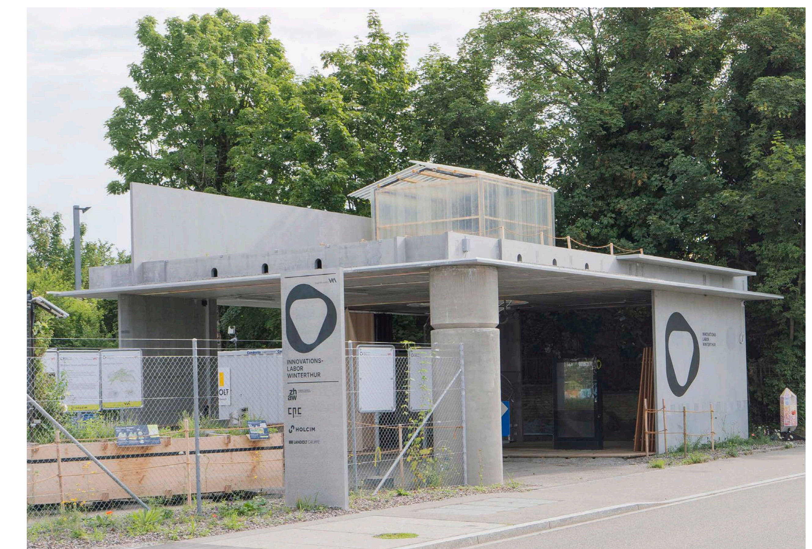
Blick von der St. Gallerstrasse.
