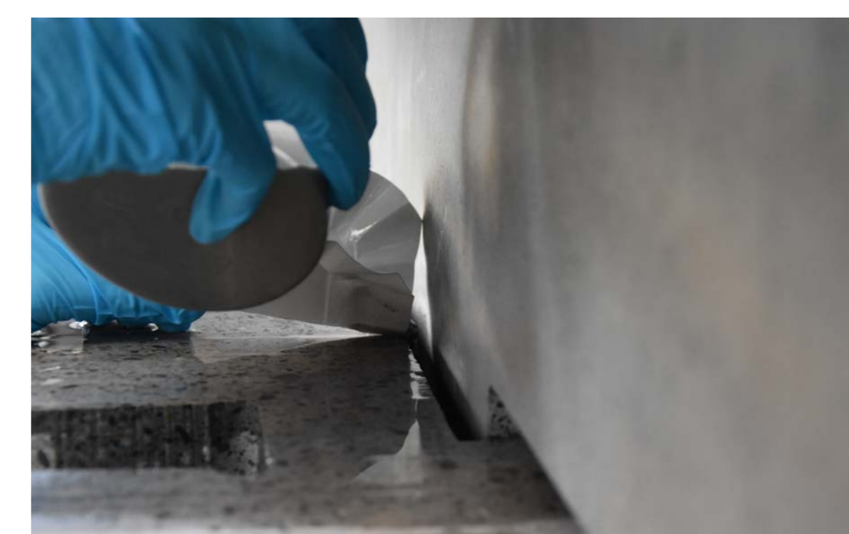
Vermörteln Turmscheibe mit Vertikalsteg
