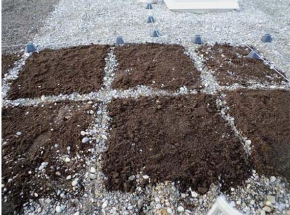
Abbildung 15: Ansaatoptimierung (Versorgung der Samen mit Nährstoffen/Feuchtigkeit) durch dünne Schichten von Gartenerde/Humus auf die aufgebrachte Vegetationstragschicht (Mischung aus sandigem Kies, Kompost, Lava-Bims), Beispiel Europaallee Zürich, Baufeld A. Foto: Magdalena Mioduszezewska
