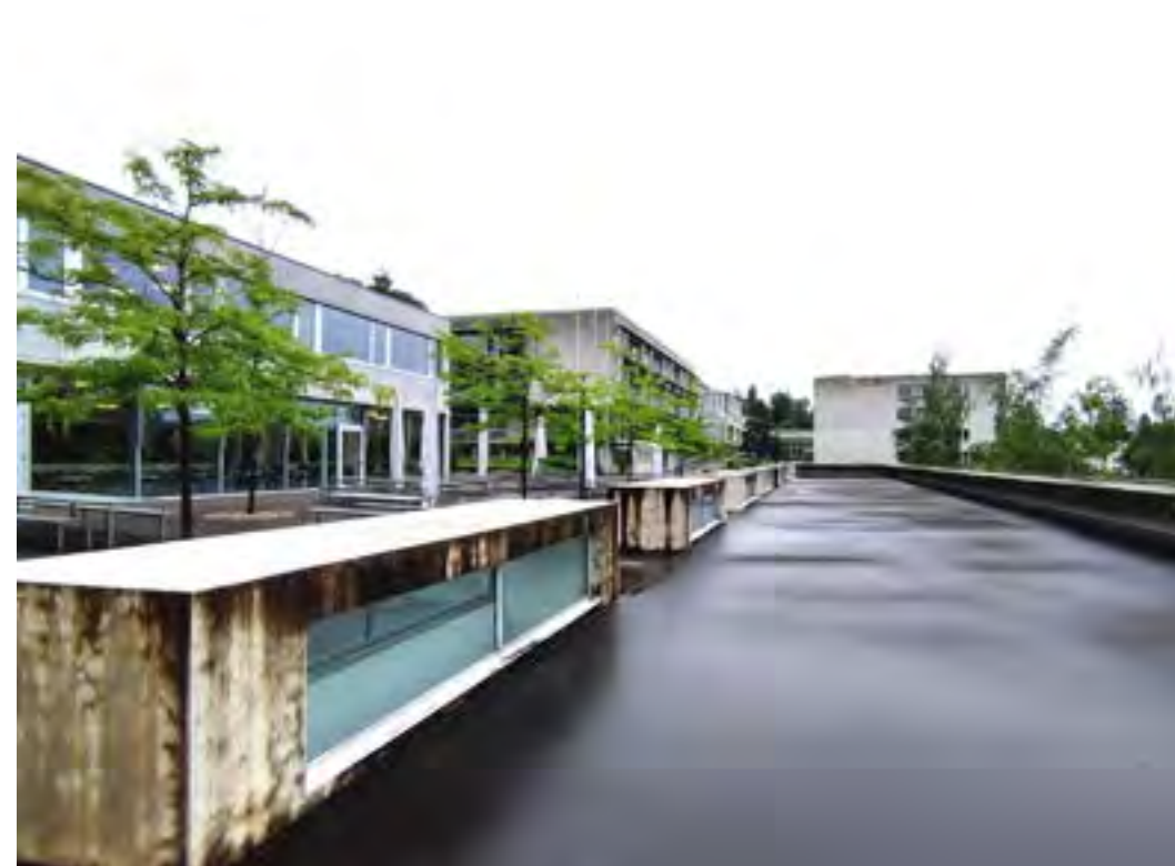
Terrasse Südtrakt, versiegelt
