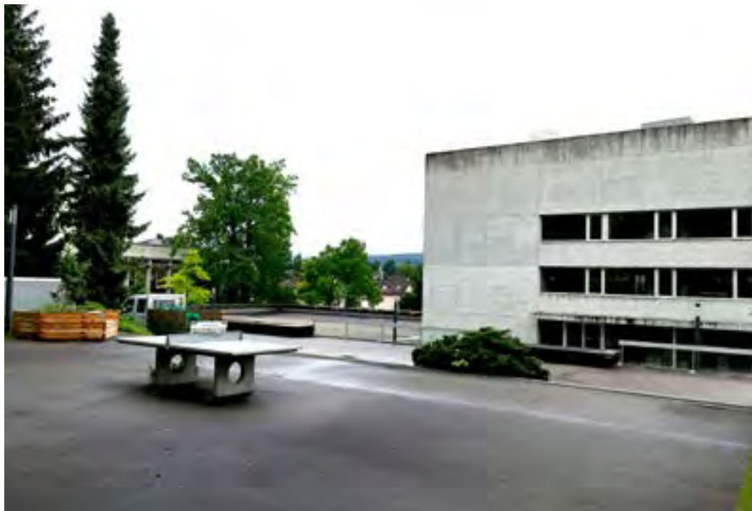
Pausenplatz Haupttrakt Ost
