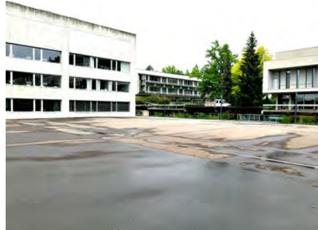
Terrasse Turnhalle Südtrakt, Vollständig versiegelter Platz
