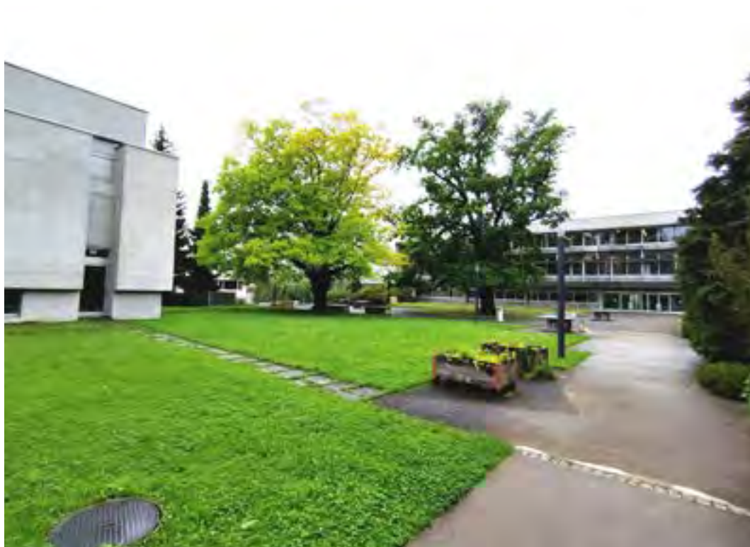
Pausenplatz Haupttrakt Ost
