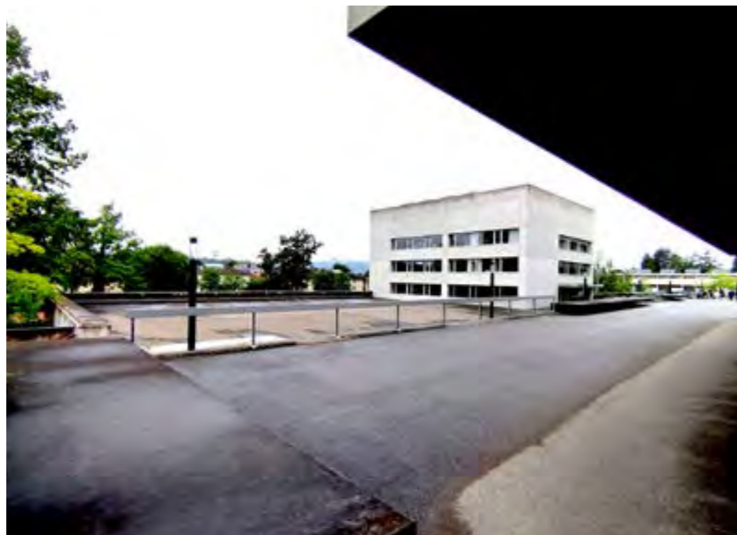
Terrasse Mensa/Turnhalle Südtrakt, versiegelt
