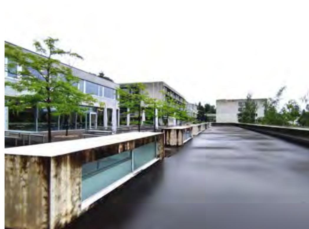
Terrasse Südtrakt, versiegelt
