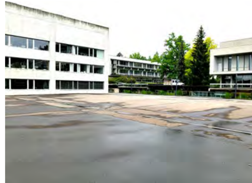
Terrasse Turnhalle Südtrakt, Vollständig versiegelter Platz
