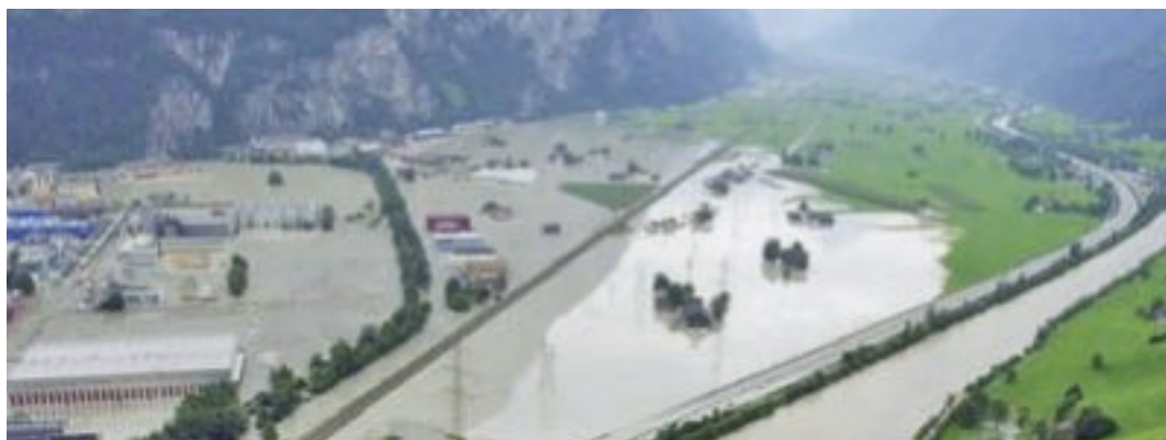
Überschwemmungen wie diese im Urner Reusstal 2005 sollen verhindert werden.
