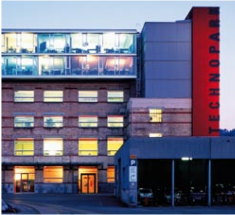
Der Technopark Winterthur: erfolgreiches Beispiel einer Public-Private-Partnership
