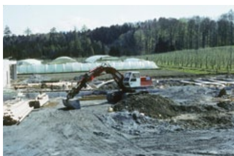
Fundamente der Gewächshäuser entstehen.
