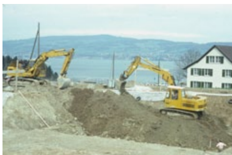
Baugrube für Grundsteinlegung und Heizzentrale im Gebäude GA.
